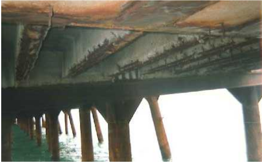
Figura 12. Vista inferior donde se observa la patología de las vigas
