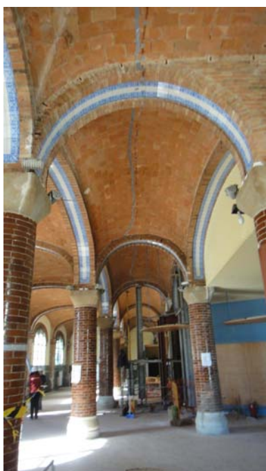
Figura 9. Vista general de la sala.
