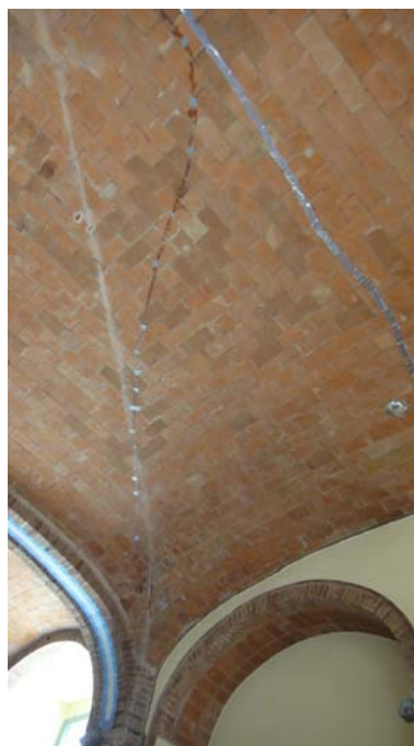
Figura 10. Detalle de la bóveda.
