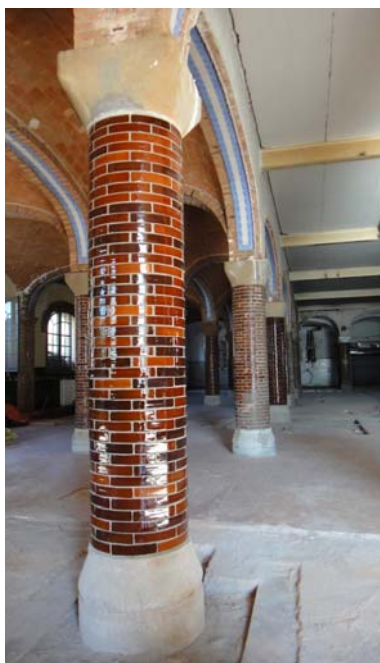
Figura 8. Pilar reconstruido.
