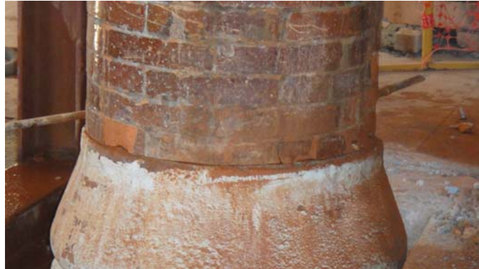
Figura 6. Corte del fuste del pilar.
