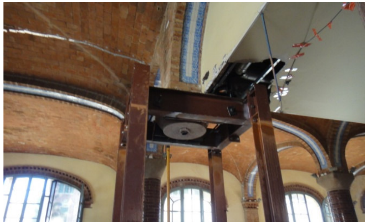
Foto 3. Pilar apeado y fibra óptica en la bóveda.
