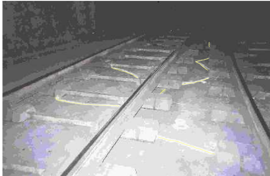
Detalle de fisuras por fatiga.
