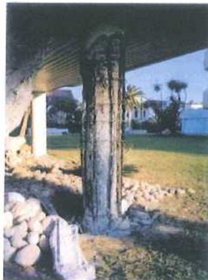
Fisuras verticales en un pilar mal reparado al que se le habían eliminado los estribos, como se aprecia al eliminar el recubrimiento. Clara repercusión estructural
