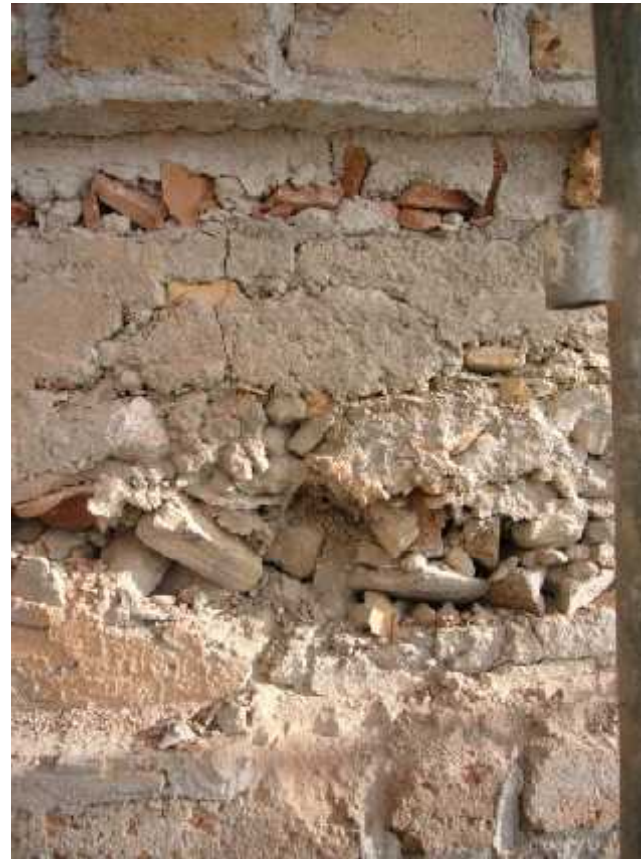
Cascotes hormigonados en tres capas en un tramo del zuncho.
