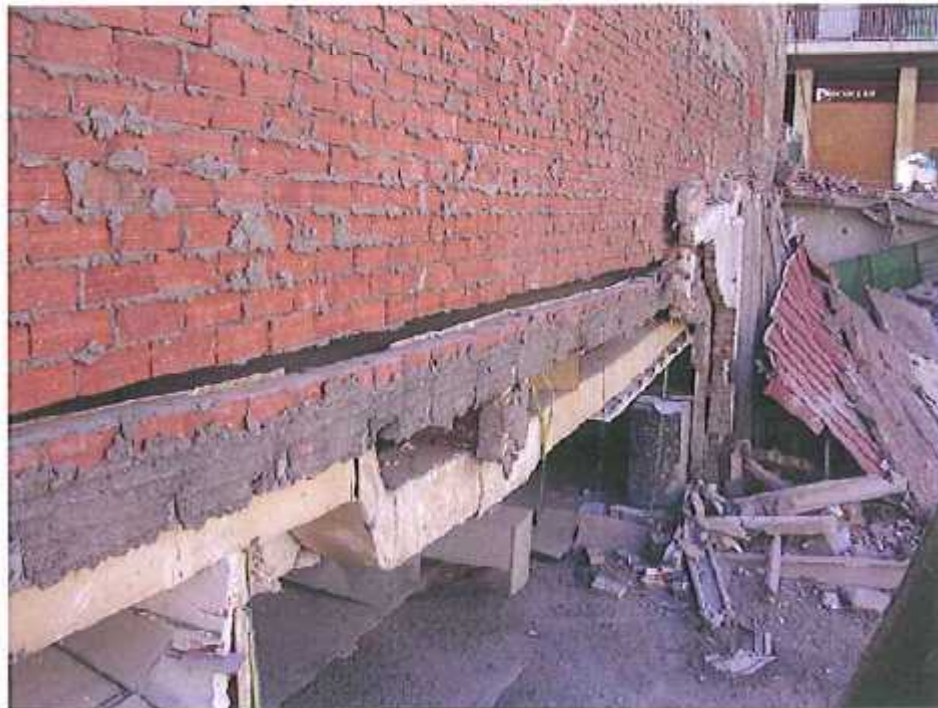
Vista del descuelgue del forjado.
