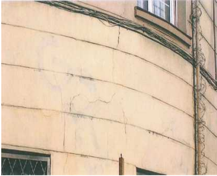
Vista de las fisuras en la fachada a la altura del zuncho. El enfoscado está desadherido.
