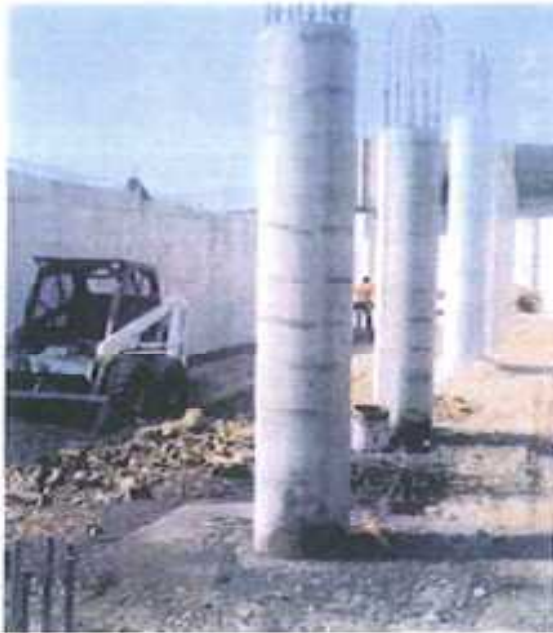
Fisuras horizontales en pilar, consecuencia de un asiento plástico. Sin repercusión estructural
