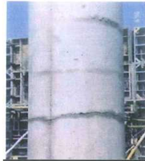
Fisuras horizontales en pilar, consecuencia de un asiento plástico. Sin repercusión estructural
