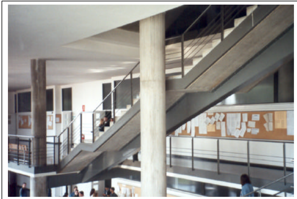
Figura 1. Vista general del tramo central
