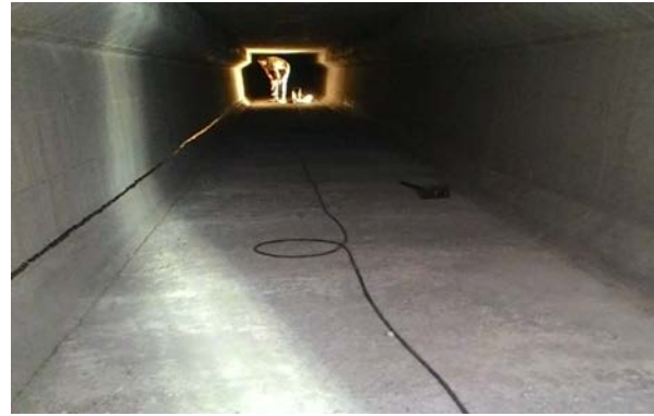
Figures 3 y 4. Procedimiento adherencia de la Fibra óptica en la base de las dos paredes laterales de la viga Artesa.
