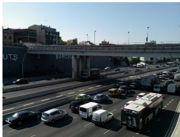
Figura 1. Puente de Sarajevo
