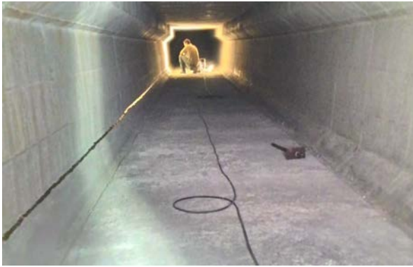
Figures 3 y 4. Procedimiento adherencia de la Fibra óptica en la base de las dos paredes laterales de la viga Artesa.
