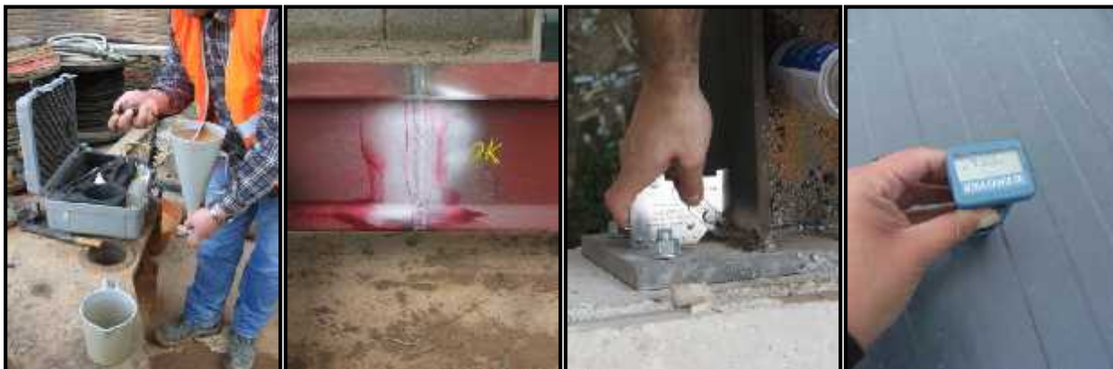
Foto 1: Ensayos control de materiales
