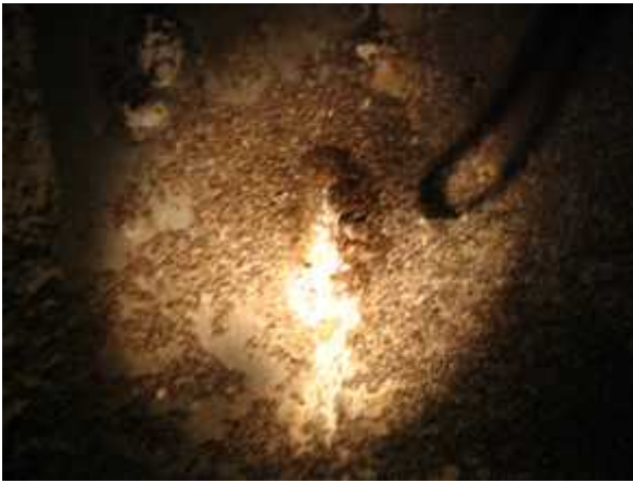
Figura 6.- Grumos en una junta
