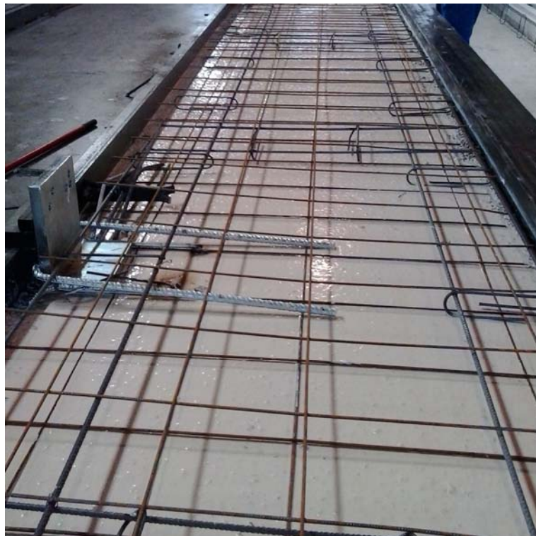
Figura 5. Fotografía del proceso de ejecución.
