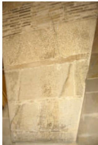
*Foto 3: Grieta en el apoyo de la bóveda en el pilar del patio.*
