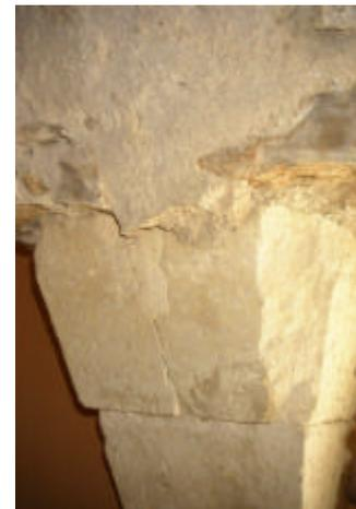
*Foto 4: Desconchados y grietas en el apoyo de bóveda en la fachada principal*
