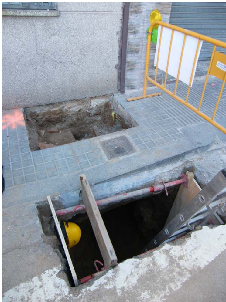
Cala fonament de l'edifici
